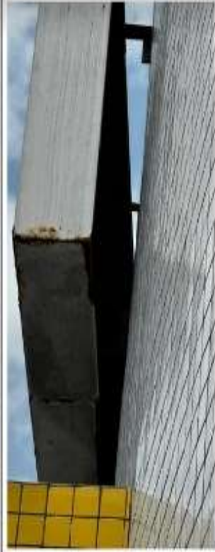
Estrutura Letreiro HMR
