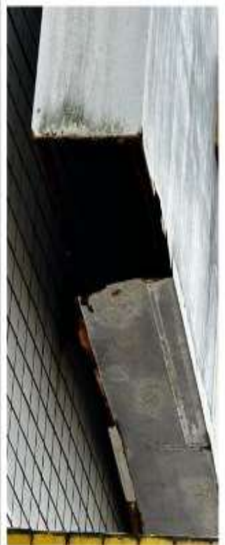
Estrutura Letreiro HMR
