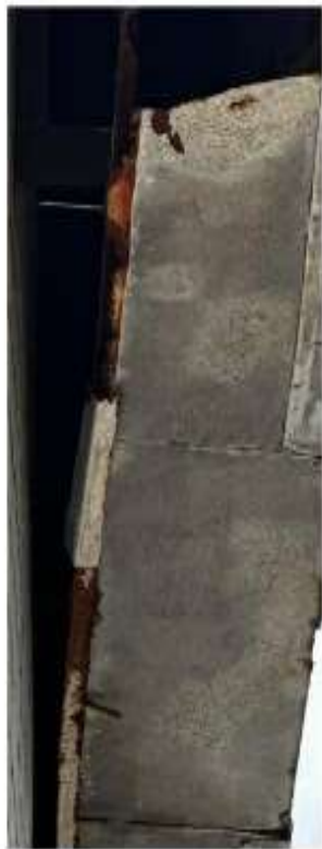
Estrutura Letreiro HMR
