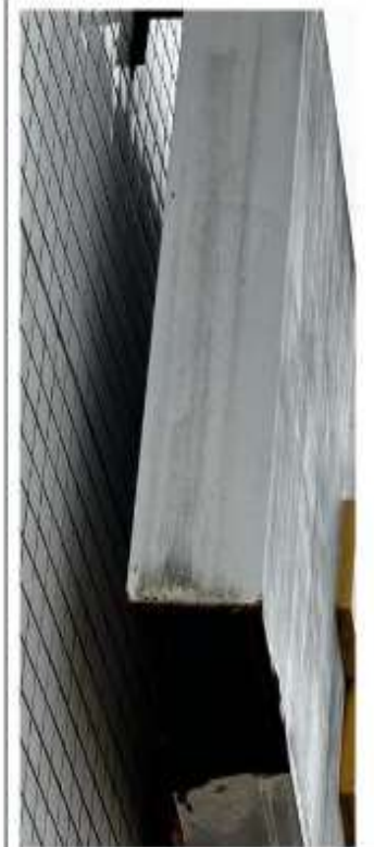
Estrutura Letreiro HMR
