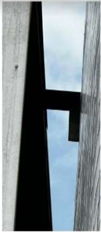
Estrutura Letreiro HMR
