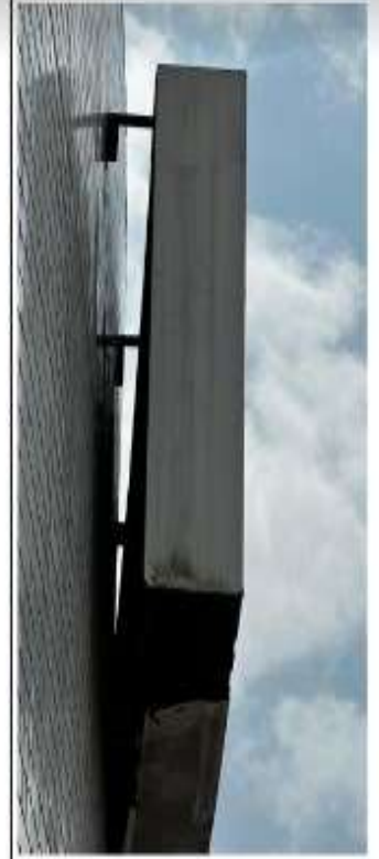
Estrutura Letreiro HMR
