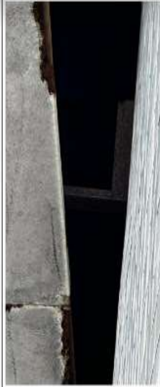
Estrutura Letreiro HMR
